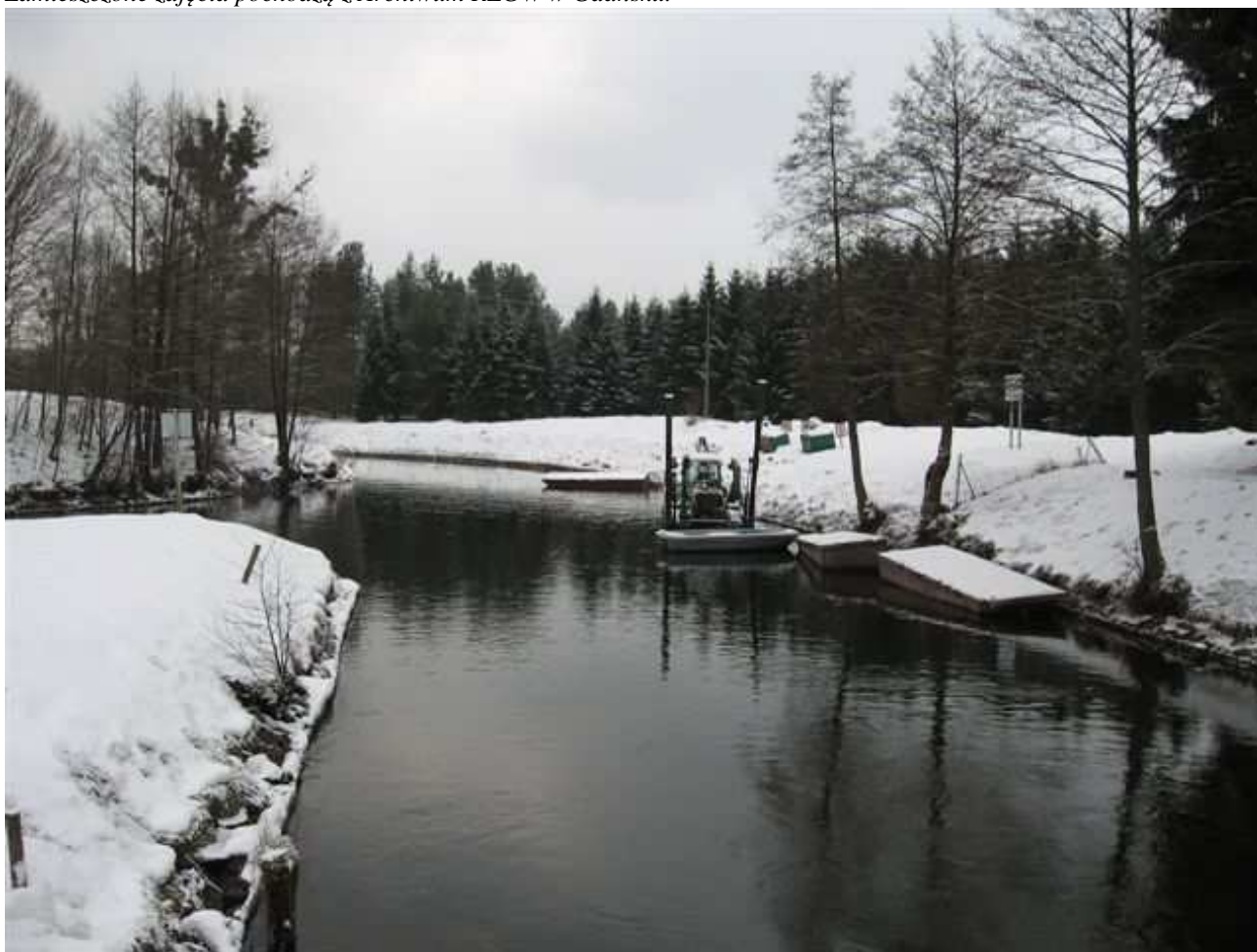
Fot. 1. Odcinek Miłomłyn – Ostróda – Stare Jabłonki (w tle widoczna tablica informacyjna).
