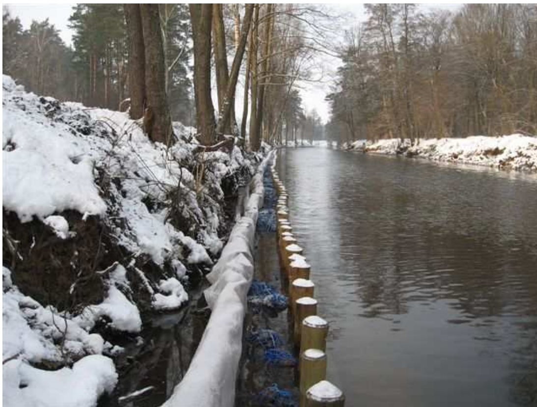
Fot. 2. Podwójna palisada drewniana na tzw. odcinku ostródzkim (umocnienie brzegowe).
