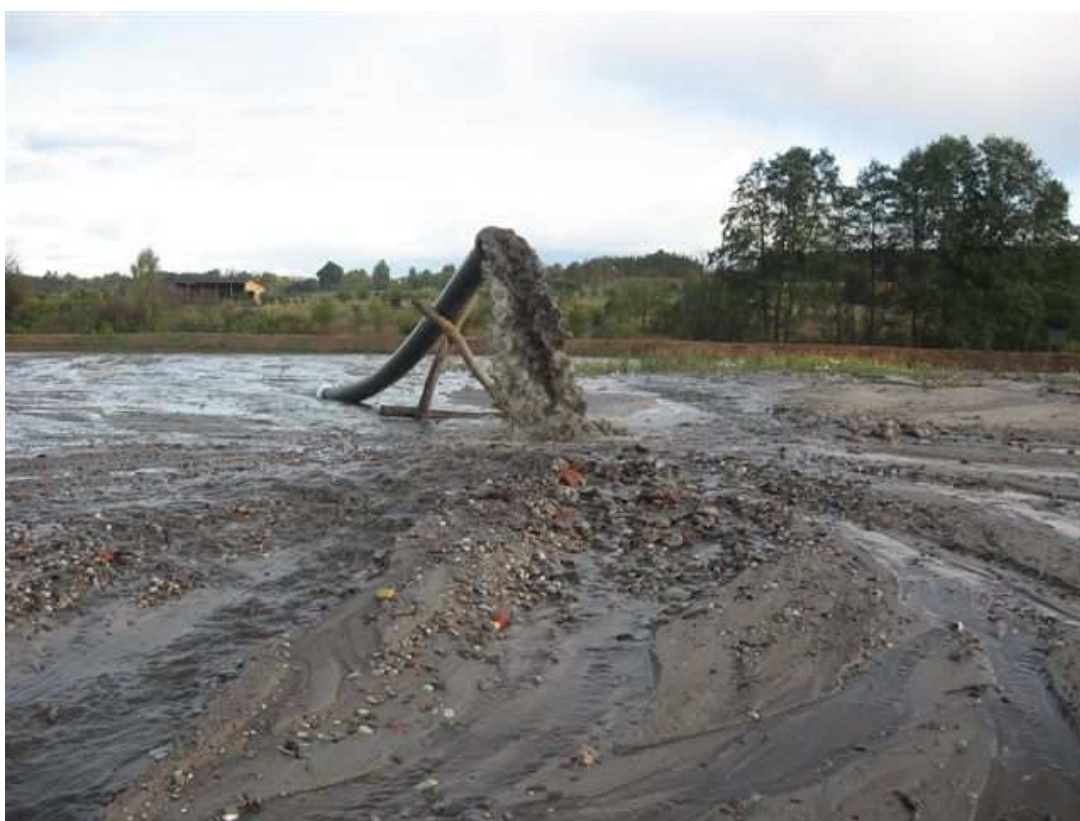
Fot. 5. Składowanie urobku na polu odkładu
