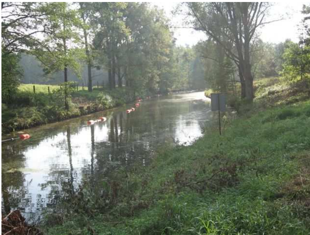
Fot. 2. Rozciągnięty w korycie Kanalu rurociąg transportujący refulat (urobek z pogłębienia koryta Kanalu)
