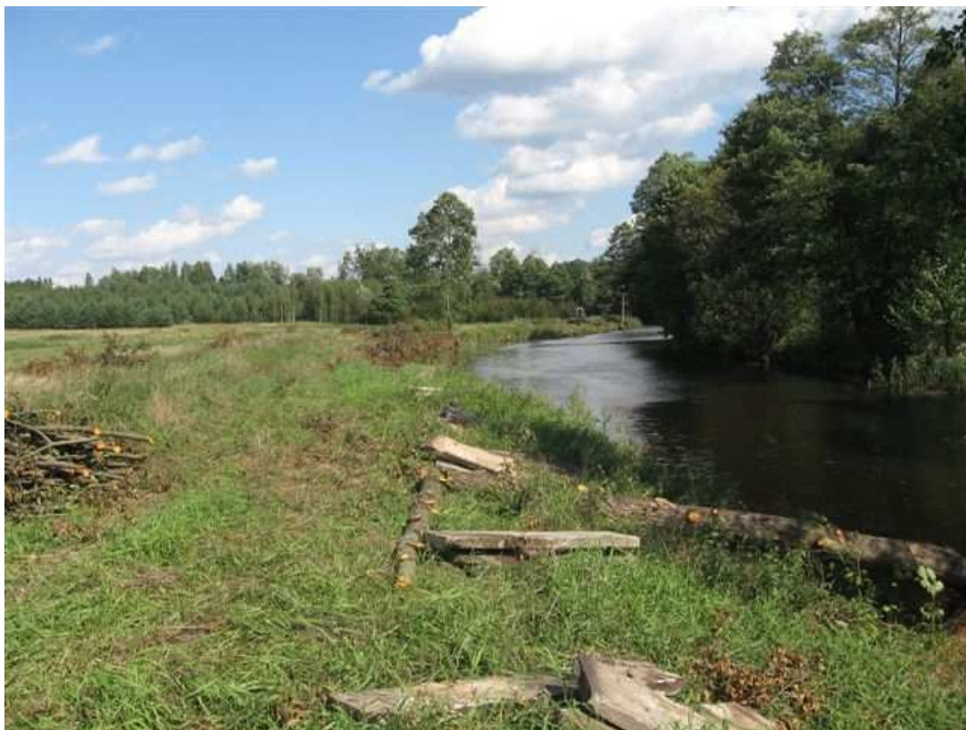
Fot. 6. Wycięte drzewa (przed przystąpieniem do prac rozbiórkowych umocnień brzegowych)
