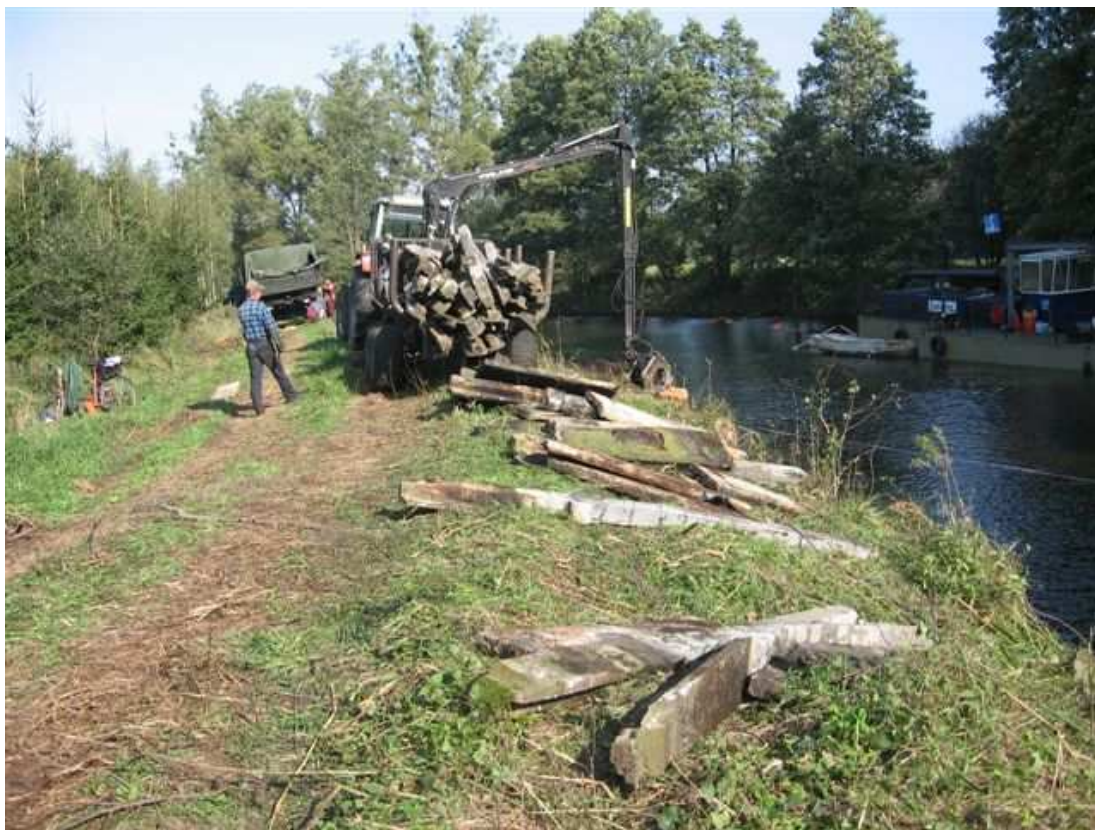
Fot. 8. Prace rozbiórkowe zniszczonych umocnień brzegowych
