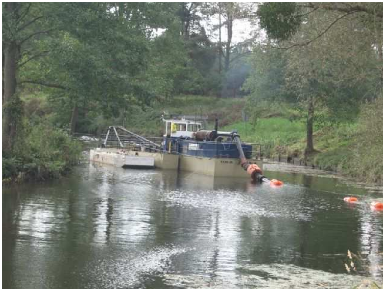
Fot. 1. Pogłębiarka w trakcie prac czerpalnych
