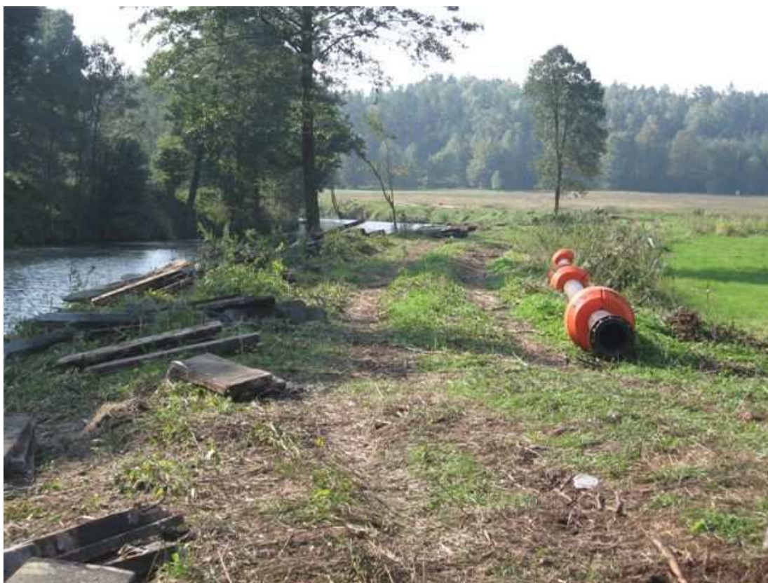
Fot. 9. Elementy zdemontowanego umocnienia brzegu z desek żelbetowych
