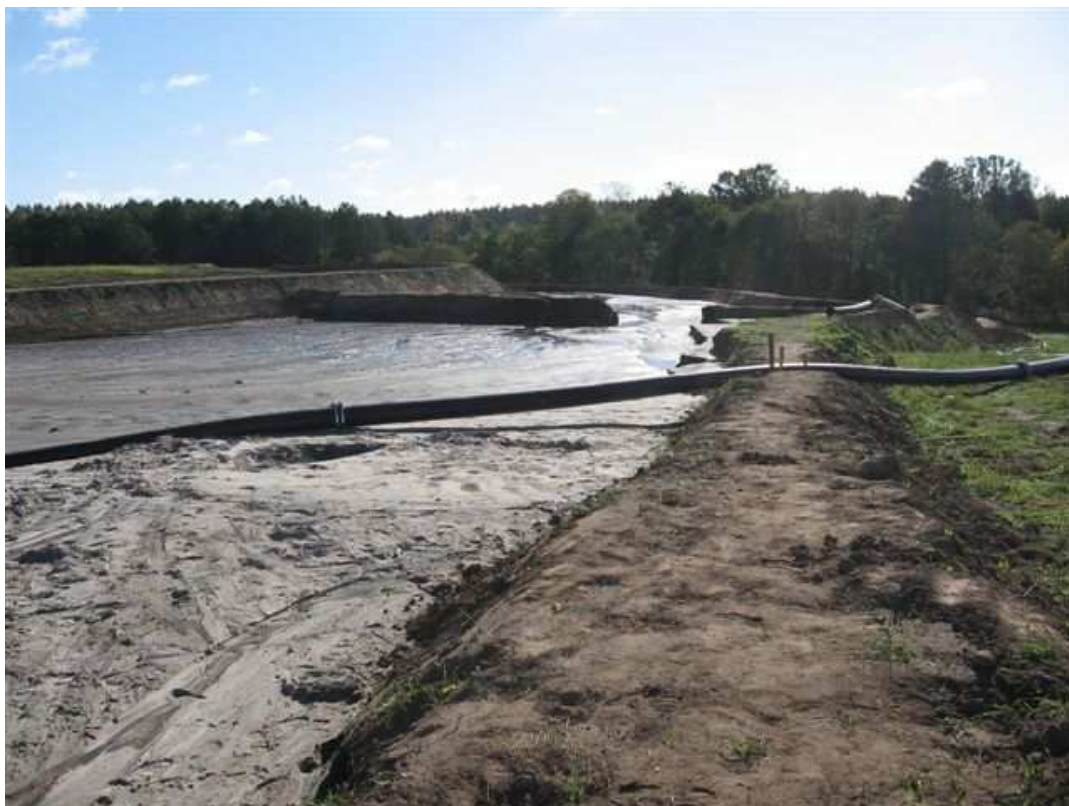
Fot. 4. Pole odkładu refulatu z widocznym rurociągiem tłoczącym
