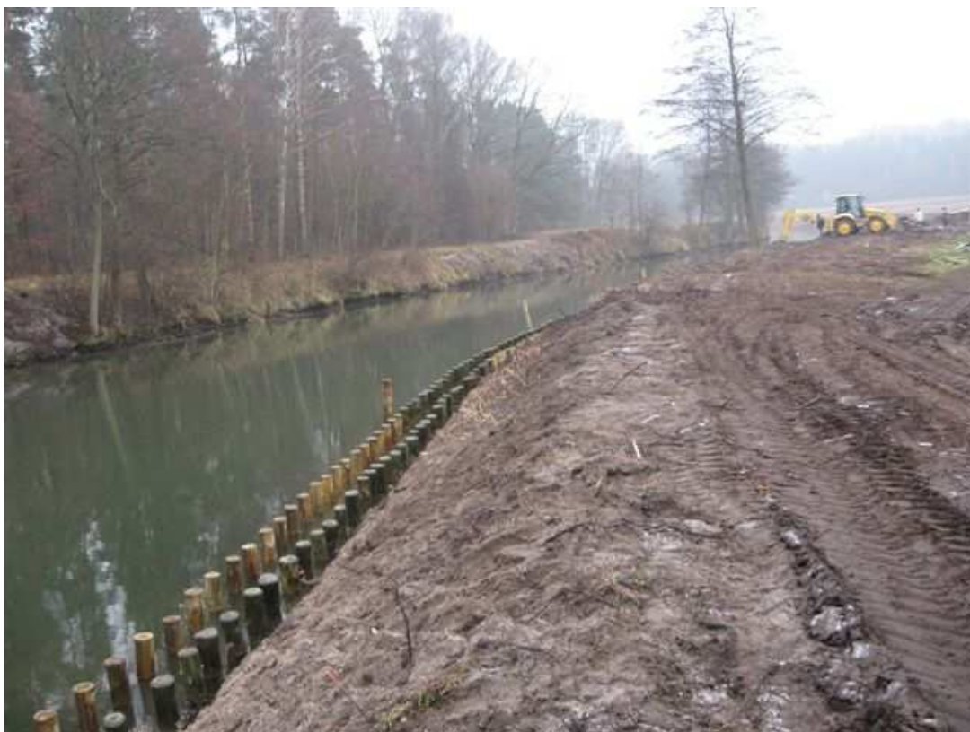
Fot. 4. Wbite rzędy pali drewnianych (element podwójnej palisady drewnianej) na tzw. odcinku ostródzkim.
