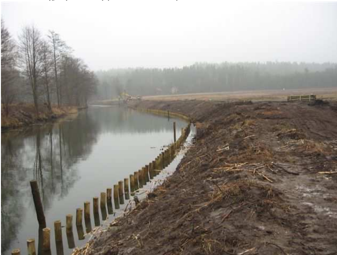
Fot. 3. Wbity rząd pali drewnianych (element podwójnej palisady drewnianej) na tzw. odcinku ostródzkim.
