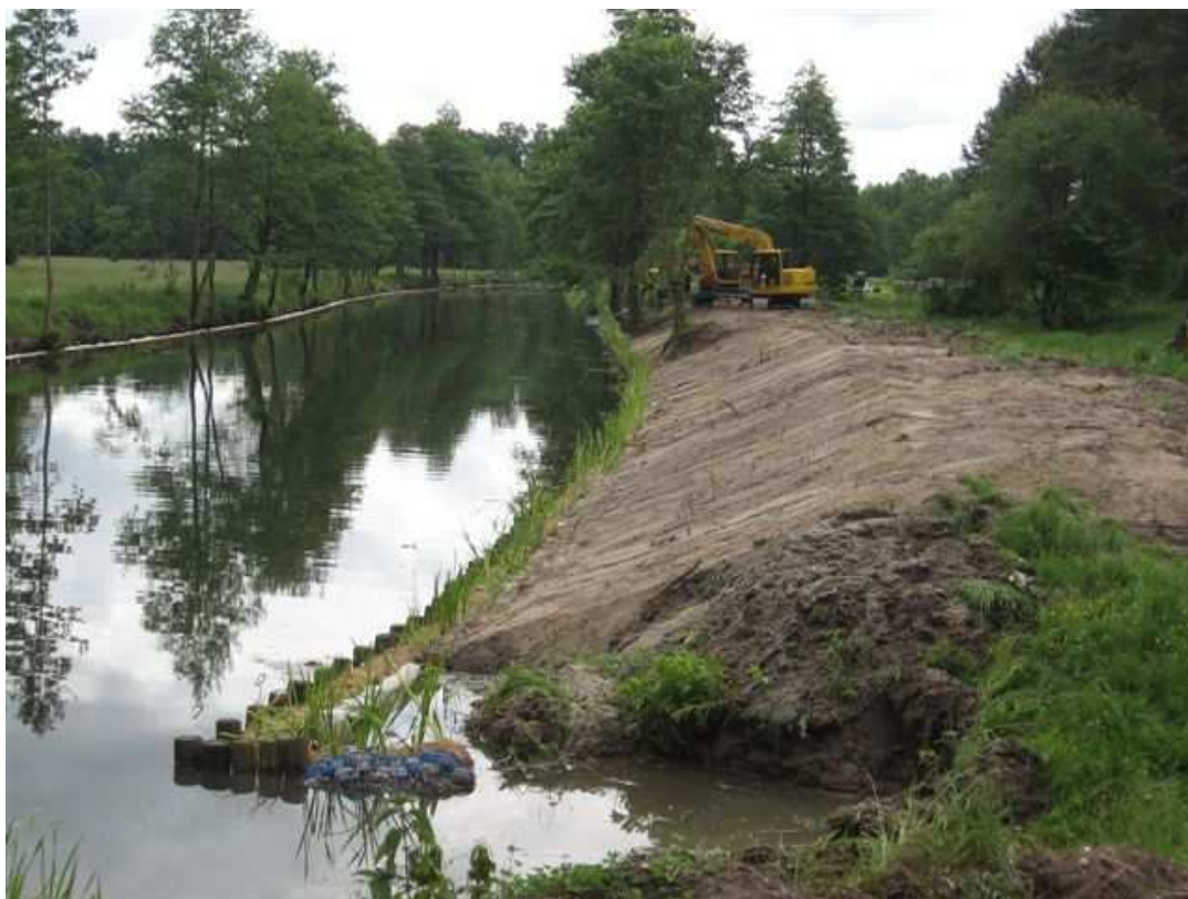
Fot. 3. Walec wegetacyjny z widocznym nasadzeniem – pomiędzy rzędami podwójnej palisady drewnianej na tzw. odcinku ostródzkim.
