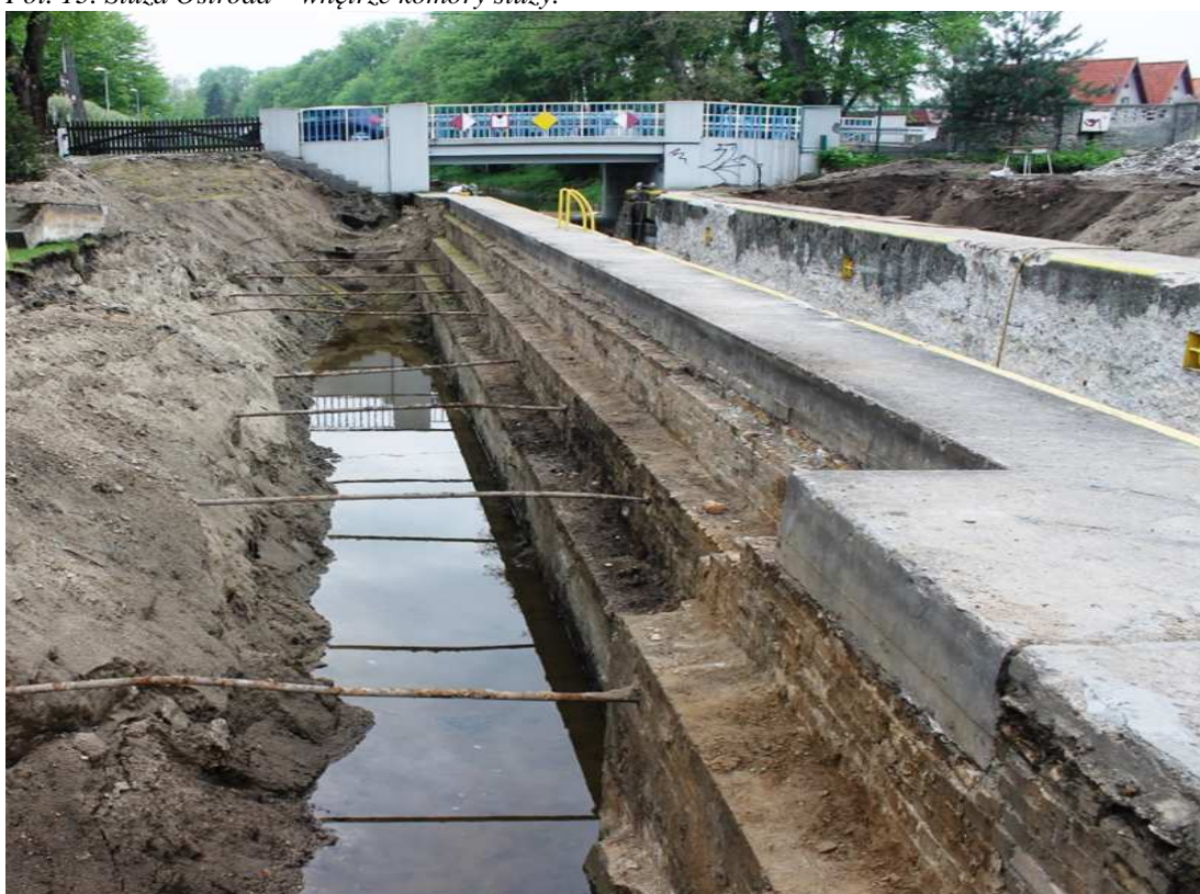
Fot. 14. Śluza Ostróda – wykop wzdłuż jednej ze ścian odwodnych śluzy.
