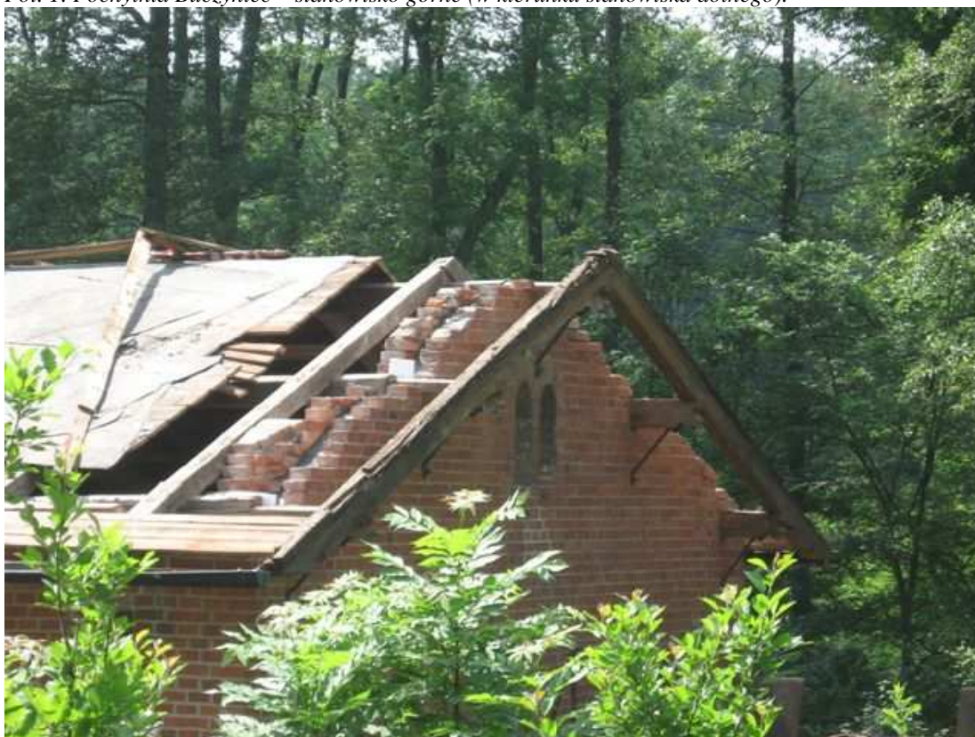
Fot. 2. Pochylnia Buczyniec – demontaż dachu maszynowni.
