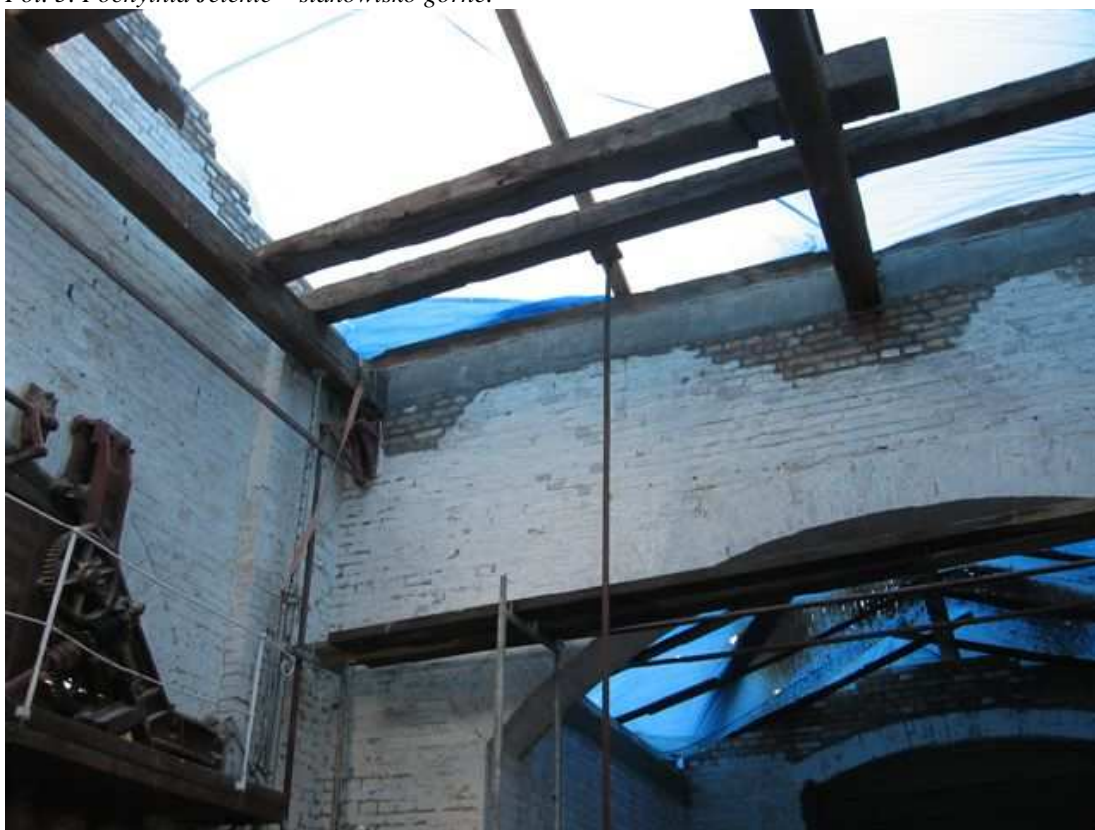
Fot. 6. Pochylnia Jelenie – zdemontowany dach maszynowni.
