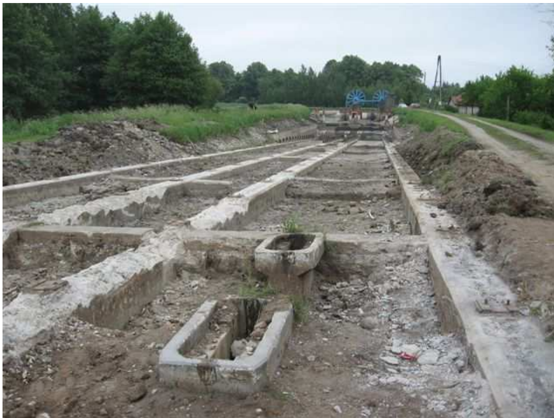
Fot. 7. Pochylnia Oleśnica – stanowisko górne.
