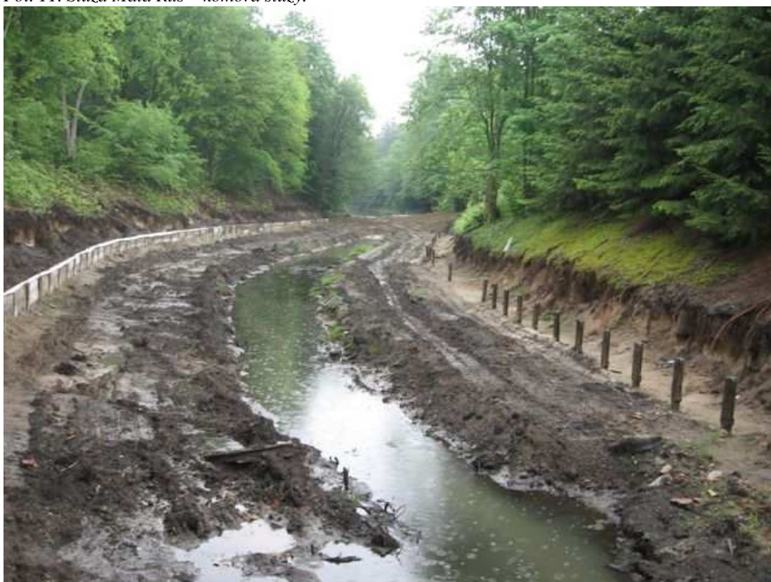
Fot. 12. Śluza Mała Ruś – umocnienia brzegowe.
