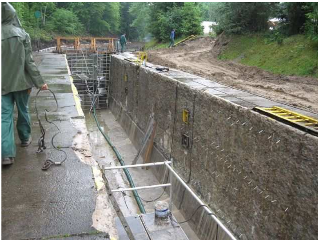
Fot. 11. Śluza Mała Ruś – komora śluzy.
