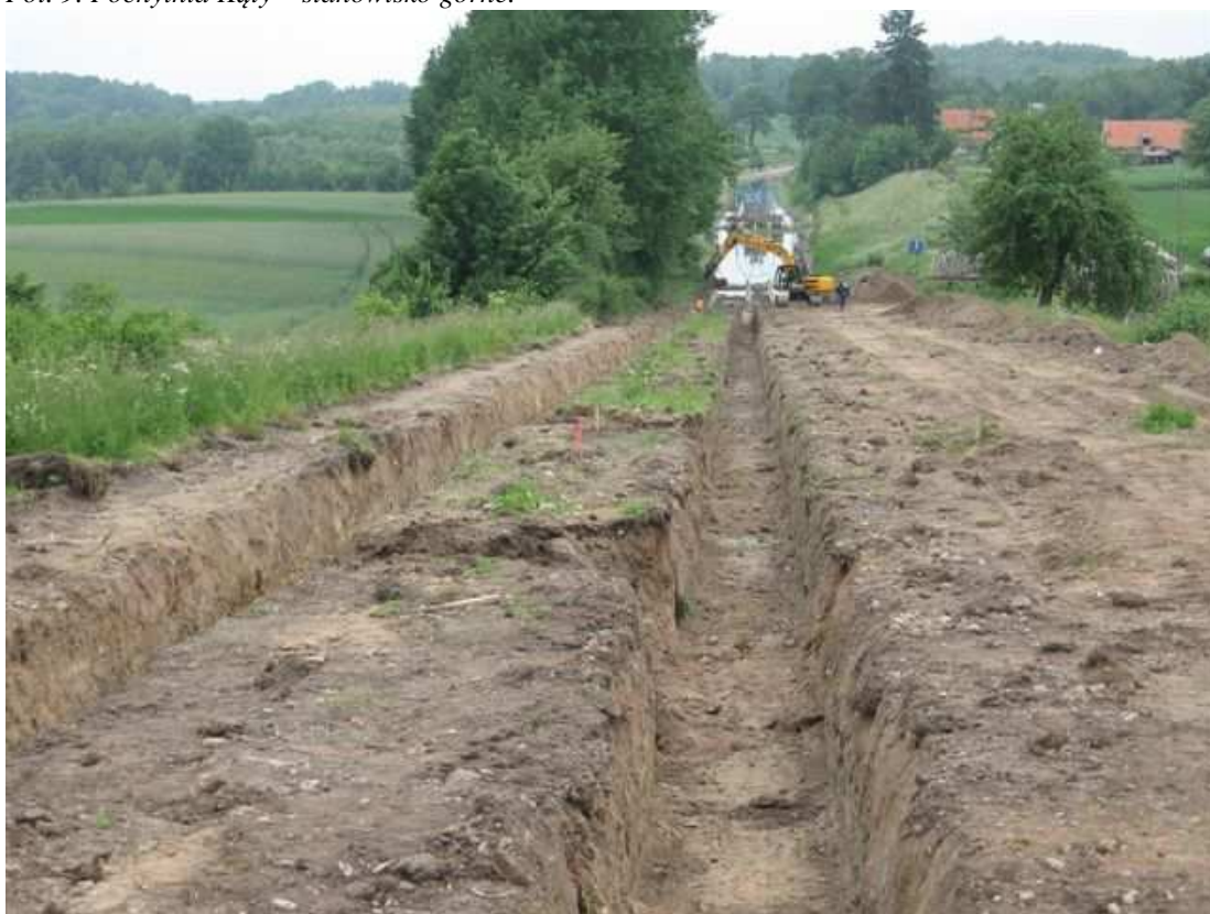
Fot. 10. Pochylnia Kąty – wykopy pod nowe fundamenty torowiska.
