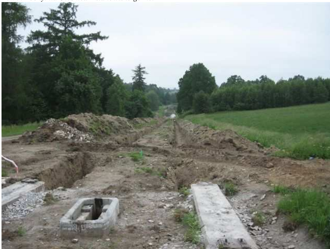
Fot. 8. Pochylnia Oleśnica – wykopy pod nowe fundamenty torowiska.
