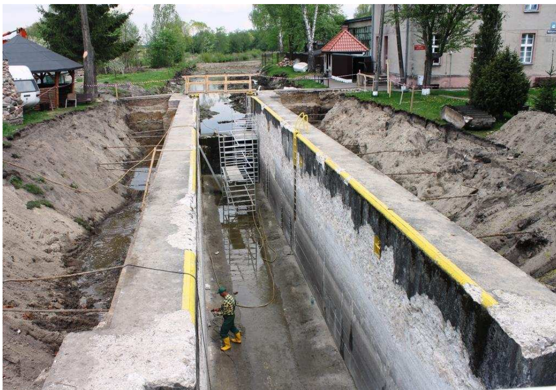
Fot. 13. Śluza Ostróda – wewnątrz komory śluzy.
